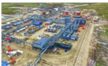
Блочно-модульная установка подготовки нефти (БМУПН)
